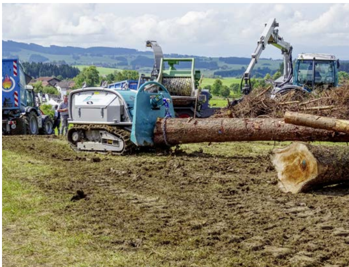
Die Fällraupe «Moritz» ist als hangtaugliche und bodenschonende Alternative zum Forstraktor mit angebauter Seilwinde gedacht.
