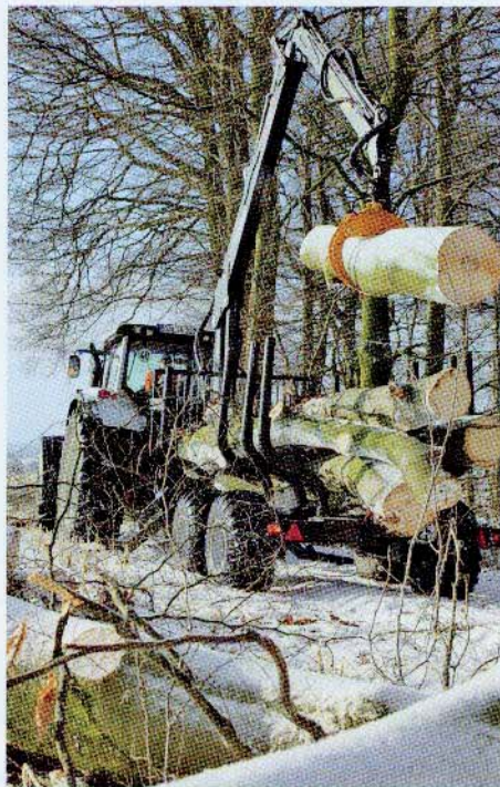
Ein Kransachverständiger muss den Kran vor der ersten Inbetriebnahme abnehmen. Auch die jährliche Prüfung muss vom Sachverständigen erledigt werden.
