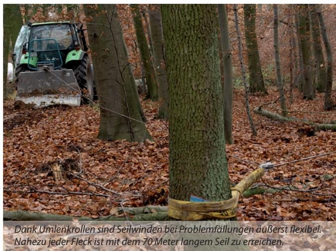
Dank Umlenkrollen sind Seilwinden bei Problemfällungen äußerst flexibel. Nahezu jeder Fleck ist mit dem 70 Meter langem Seil zu erreichen.
