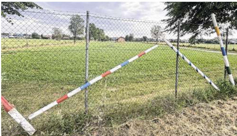
Der Zaun um den Brunnen in Altdorf muss erneuert werden. Er soll künftig aus PV-Modulen bestehen. Foto: Irmgard Altenberger
