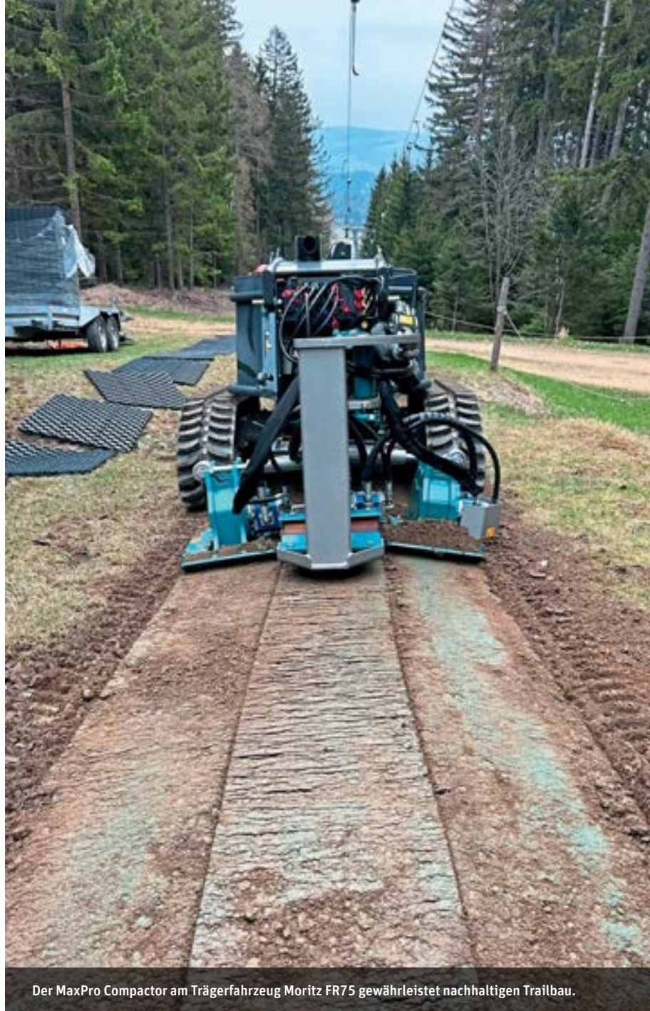
Die drei schwenkbaren Verdichterplatten vom MaxPro Compactor passen sich optimal an die Geländeformen an.
